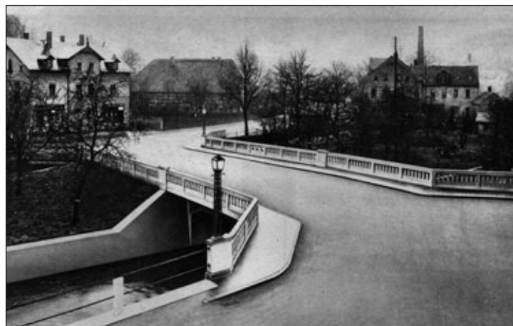
Die untere Eisenrahmenbetonbrücke mit Mühlgrabenüberbrückung 1928
