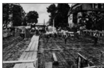
Rahmenbinder werden betoniert. Eisen der Brückenplatte verlegt. Beginn der Plattenbetonierung
