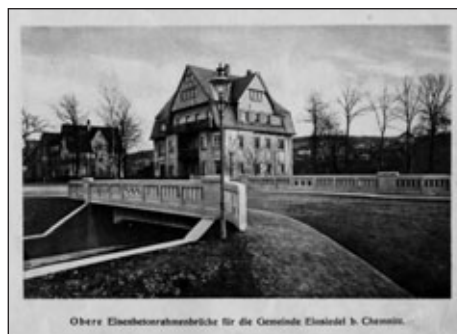
Die Durchbiegung nach den Ergebnissen der Probebelastung im Kleinstwert erreicht und vollkommene Elastizität festgestellt.
