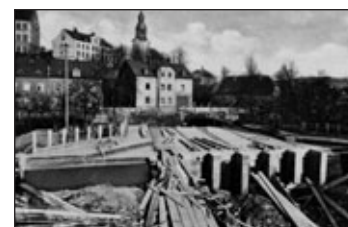
Zwönitzfluß und Mühlgrabenbrückenplatte betoniert, in Vorbereitung Brüstungsbau und Gefälllaufbeton.
