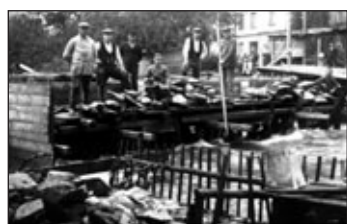
Sie hat unter größter Hochwassergefahr im Juli 1926 ihre Standfestigkeit bewiesen.
