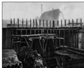
Lehrgerüstbau mit 4 Flutöffnungen bei Niedrigwasser (im Hintergrund sichtbar ehemaliges Guido Schmidt Gut und Esse der Strumpffabrik Brückner)
