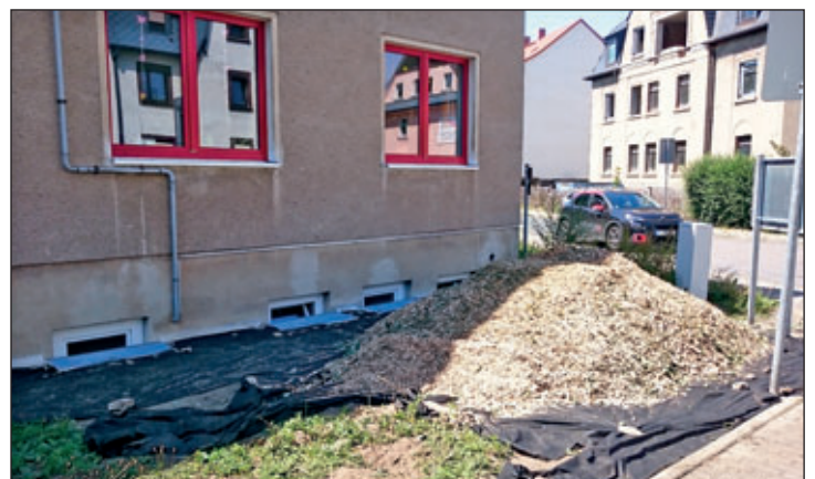
Eine der Baustellen am und um den CLUB, für die jederzeit Unterstützung und helfende Hände gebraucht werden.
