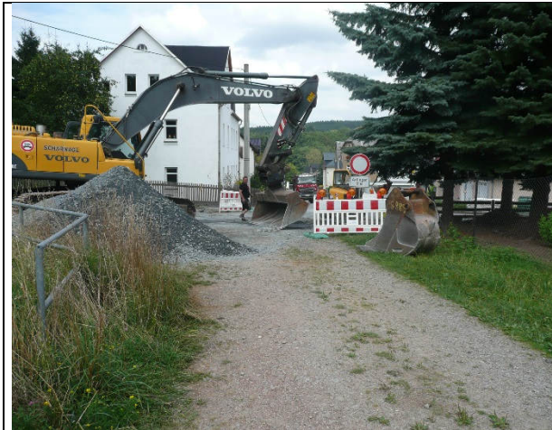
Erschließung von der Eibenberger Straße
