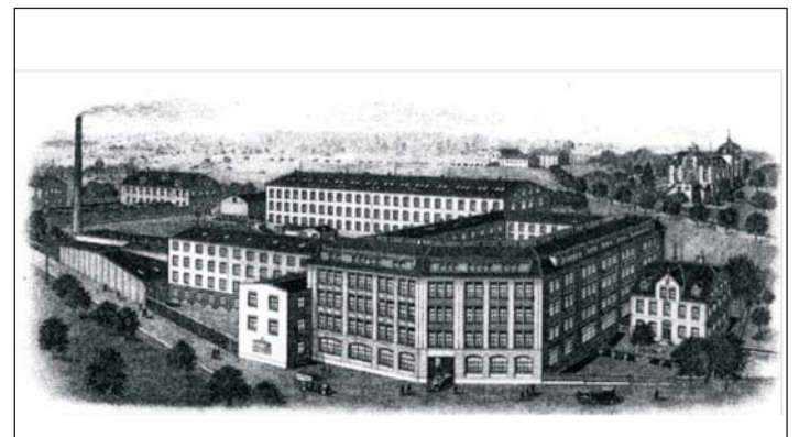
Ehemalige Fischermühle Fabrikneubau Prokuristenhaus und Villa
