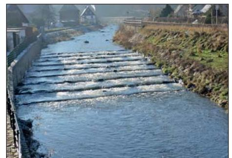
Die Kaskaden dienen der Reduzierung der Fließgeschwindigkeit.
