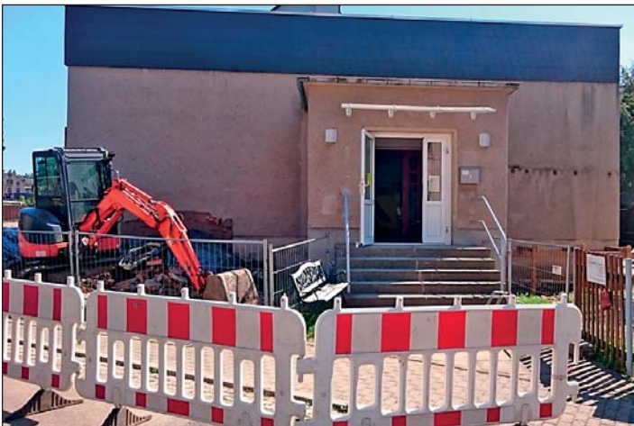
Impression kurz vorm Abriss der Eingangstreppe Ende Mai, im Garten die Berge aus Bauschutt...
