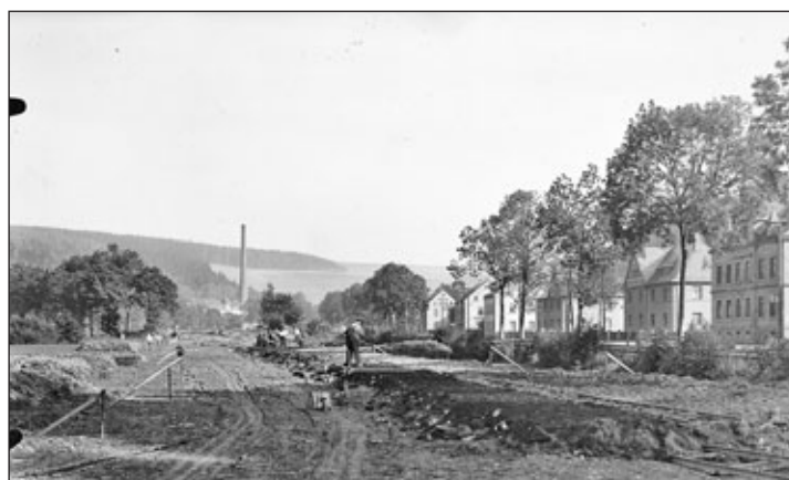
Arbeiten an der Trasse. Blickrichtung Hübel und Papierfabrik und ihrer noch vorhandenen Esse.
