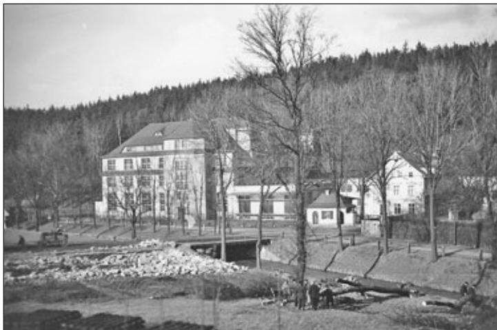
Die Anschlussgleisbrücke, im Vordergrund der noch vorhandene Bauschutt vom abgerissenen Gebäude, das zur Papierfabrik gehörte. Baumfällungen schaffen ebenfalls Baufreiheit.
