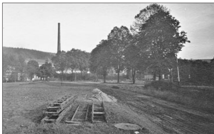
Entlang der Bäume der Verlauf des Anschlussgleises vom Bahnübergang, rechts ist eine Schranke erkennbar.
