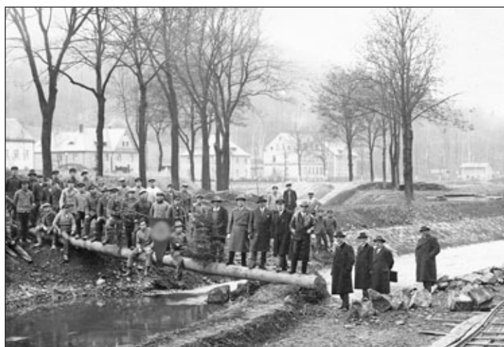
Die Umleitung der Zwönitz erfolgte 1937, wahrscheinlich im Dezember. Im Hintergrund rechts das Bahnwärterhaus in Erfenschlag.
