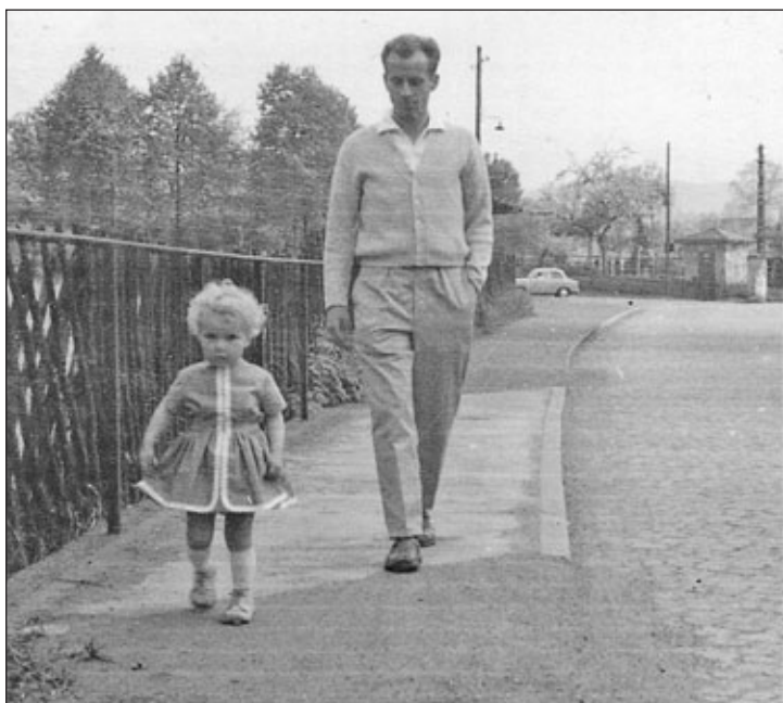
Das Foto zeigt die betonierte Abdeckung des Mühlgrabens in Höhe des Hauses Fasold mit noch vorhandenem Originalgeländer (Aufnahme K. Böttger 1963)
