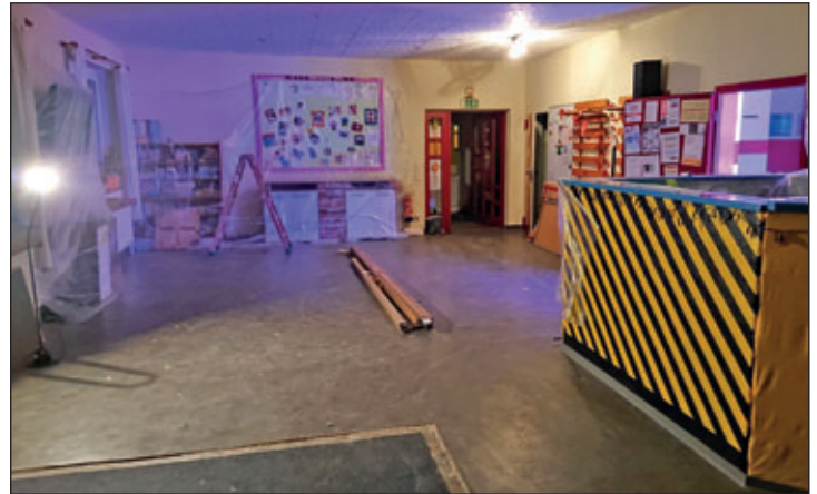
Die neue Decke mit einstellbaren LED-Lampen wurde Mitte November eingebaut.
