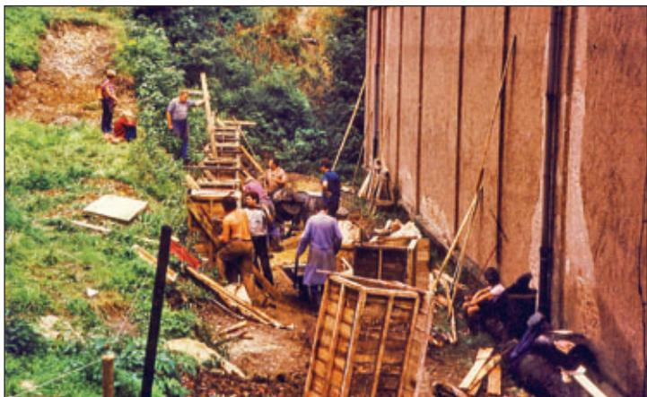
Im Sommer 1974 wurde mit den Bauarbeiten begonnen. Auf dem Foto sehen wir die Arbeiten für das Fundament und die Säulen, welche die Bahn später tragen werden.
