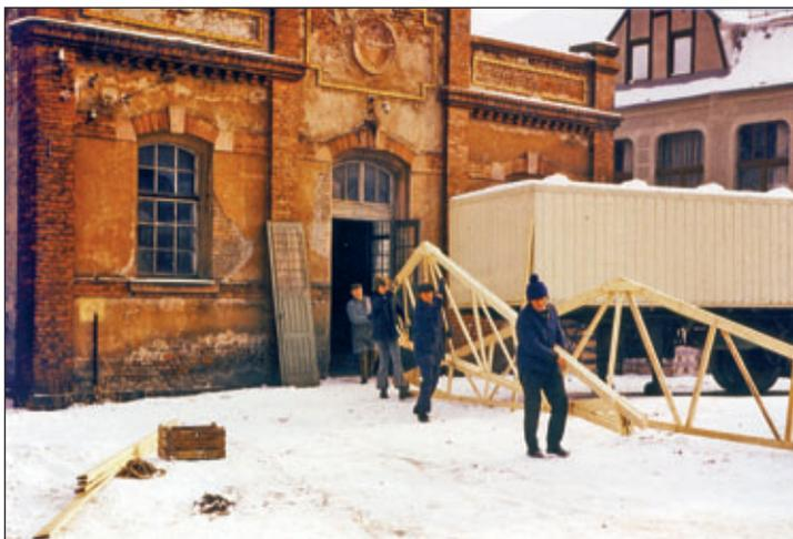
Die Dachbinder wurden im Sägewerk Kunze aus den Bäumen, die vor dem Bau der Kegelbahn ebenda gefällt wurden, hergestellt und in der alten Turnhalle zwischengelagert.
